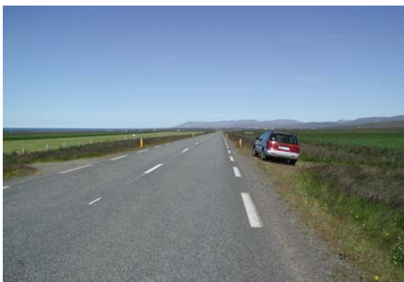
1 k9-03 Hringvegur, sunnan við Blönduós
